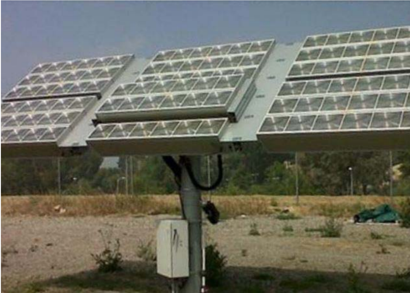
6-Module CSP Array
